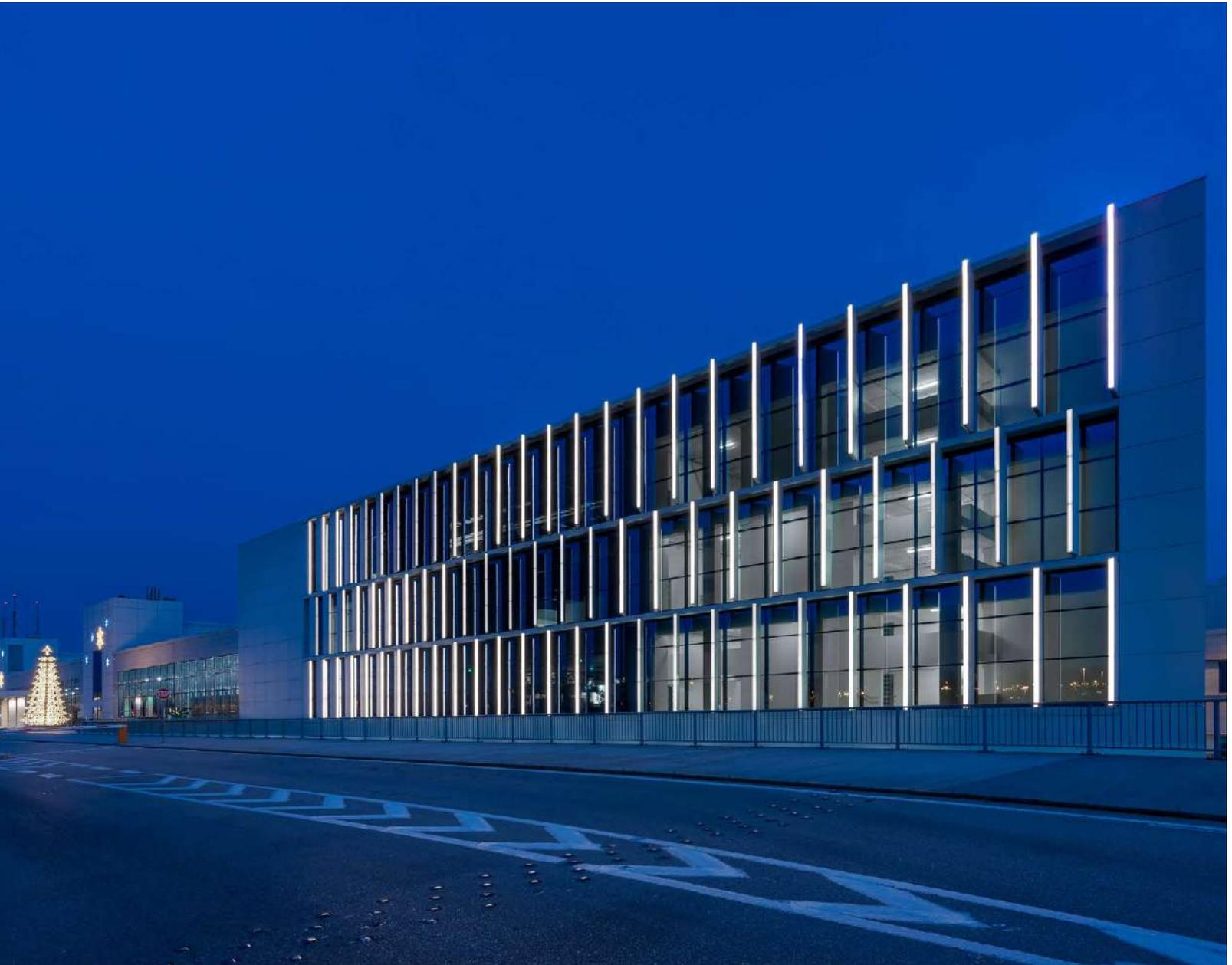
El resultado aportado por los 253 módulos, fabricados en policarbonato y con clasificación IP67 de resistencia a los agentes atmosféricos, es espectacular: líneas blancas sencillas y elegantes se intercalan con escenografías de colores, con efectos estáticos o dinámicos, definidos o que se difuminan, que se iluminan y se apagan.
